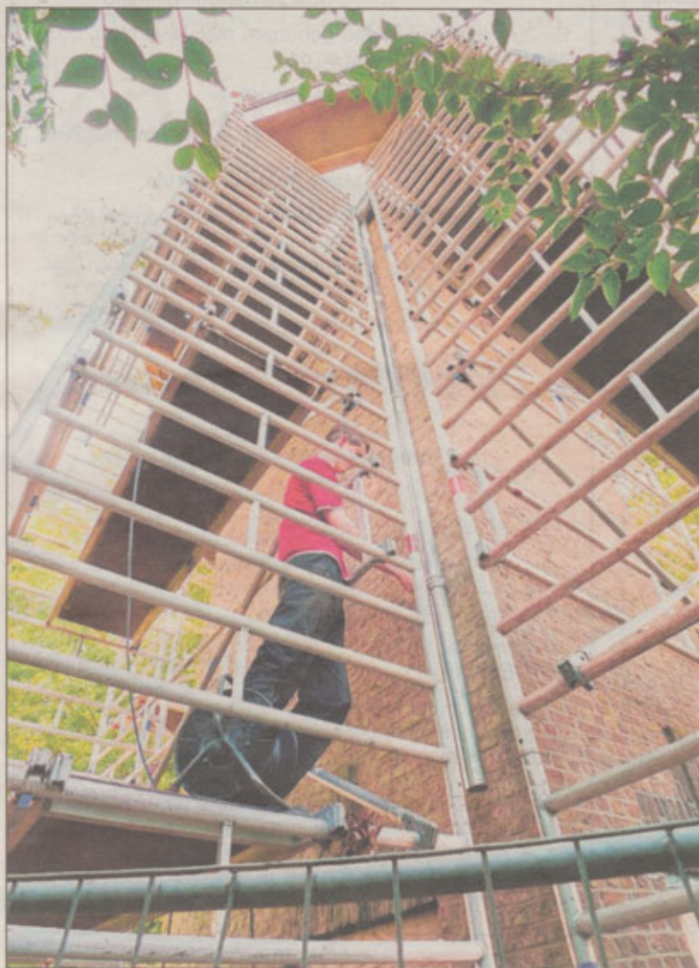
Het uit 1928 daterende elektriciteits-hoogtorenstation in Dreischor krijgt een opknabbeurt. foto Ronald den Dekker
